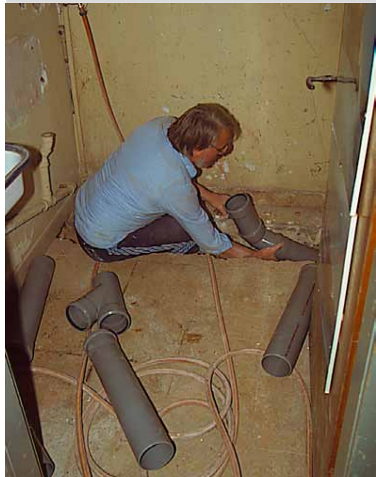
Abb. 9: Umbau, im neuen Vereinsheim, Klaus Gebhard verlegt die Kanalisation; Foto: Thilo Müller
