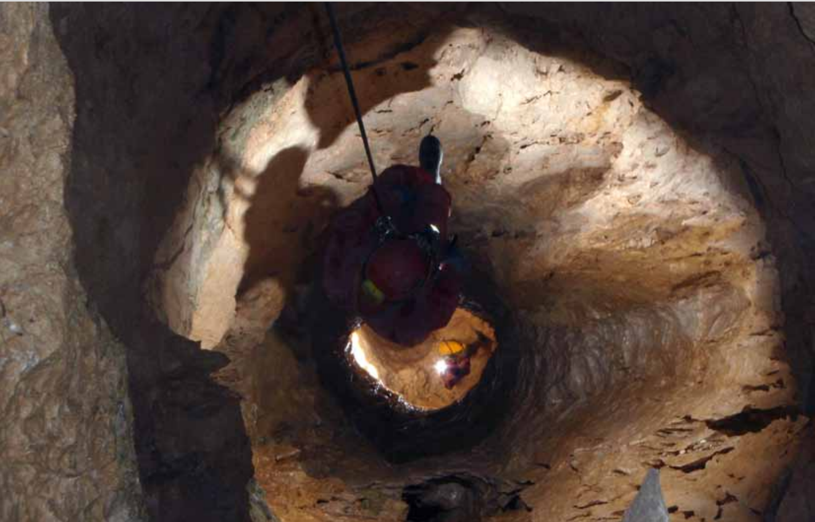
Abb. 5: DN 3000 wird der Schacht mit einem Innendurchmesser von drei Metern von Uli getauft; Foto: Uli Nohlen
