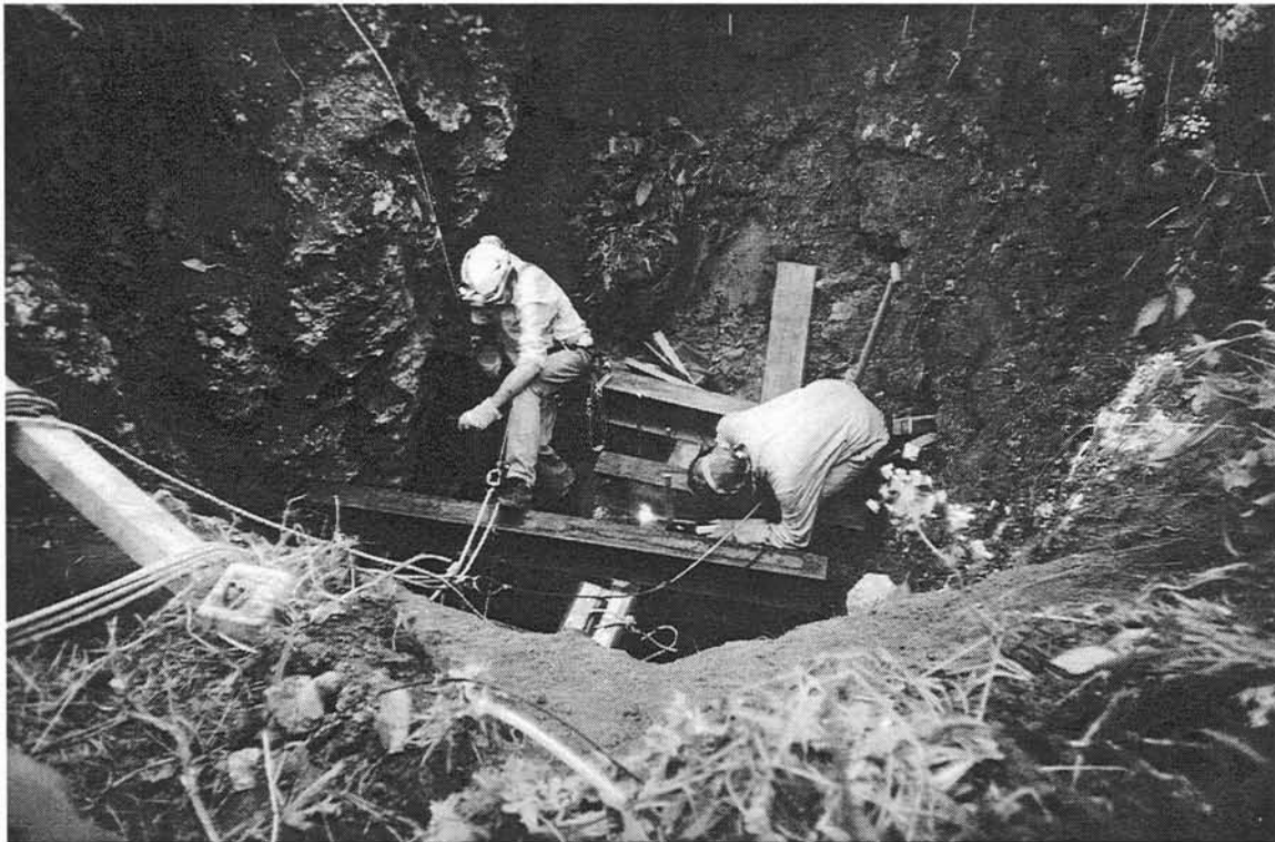
Abb. 3: Fundamentieren und verschweißen der Doppel-T Träger. Man beachte: Die Sicherung von Jonny Kirsch (rechts) besteht aus einem Edelstahl-Tau – als Sicherheitsmaßnahme beim Schweißen. Aufnahme: Thilo Müller
