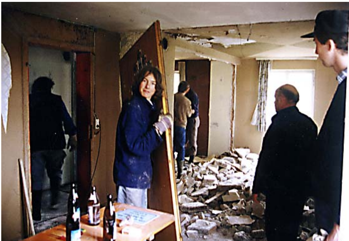
Abb. 6: Rohbaumaßnahmen am ersten Arbeitstag, Mai 1994; Aufnahme: Thilo Müller
