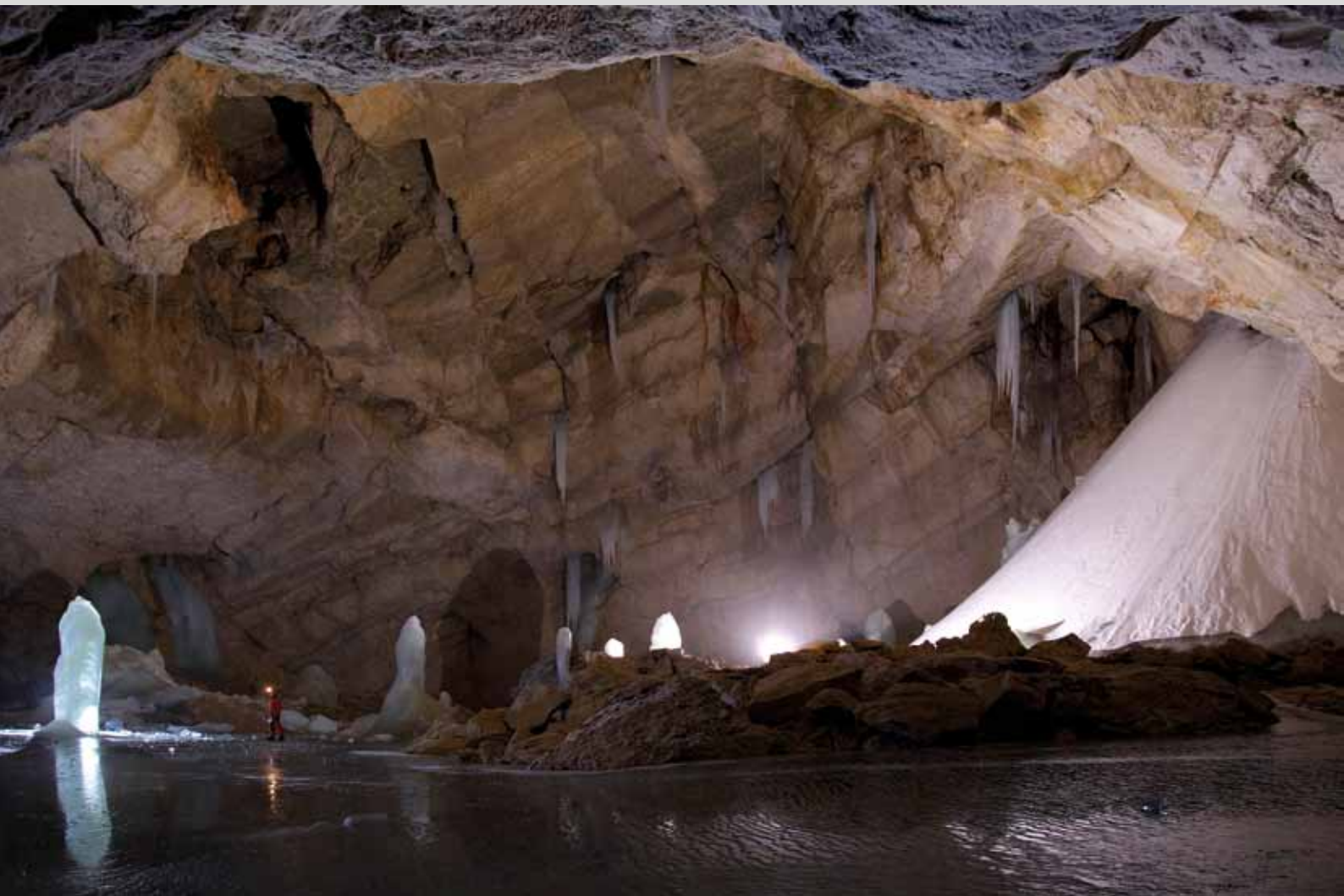
Abb. 10: große Eissäule und absturzgefährdete Eisstalaktiten (Folgeseite)
