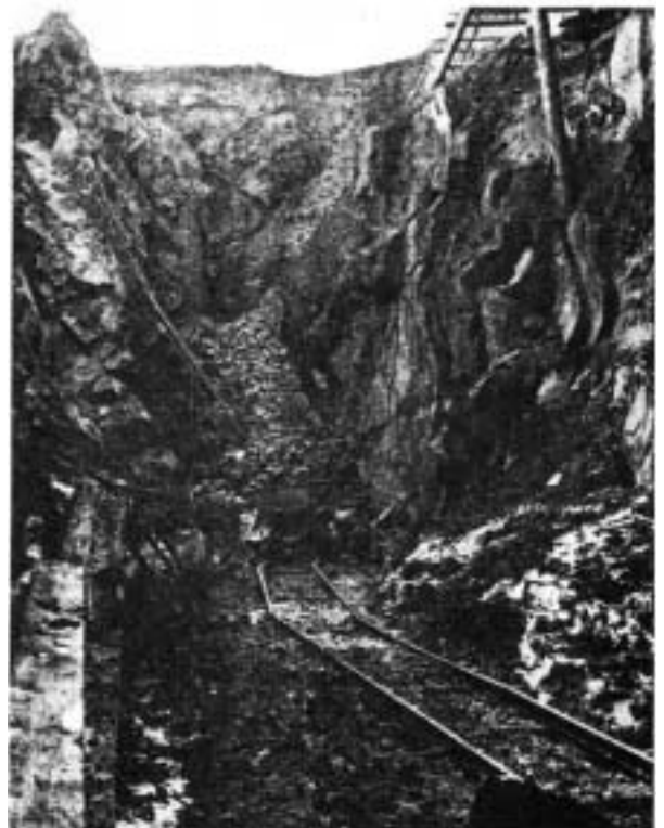
Abb. 8: Abbaustelle des Steinbruchs nach Westen um 1933. Abb. aus Schwenkel, 1936
