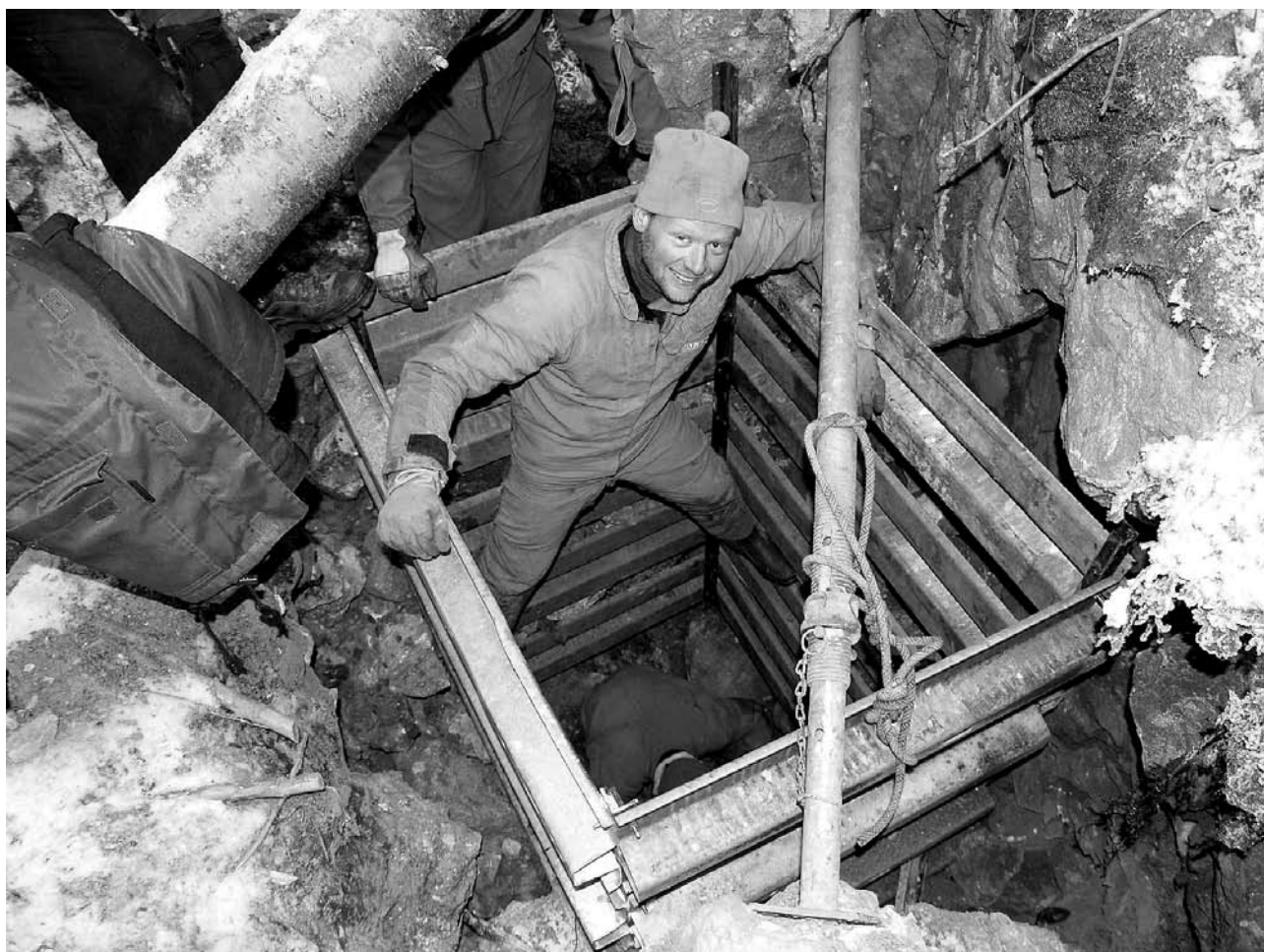
Abb. 5: Am 4. Grabungstag (28.1.06) war dann schließlich das Ei des Kolumbus gefunden: Verbau mit Leitplanken;
