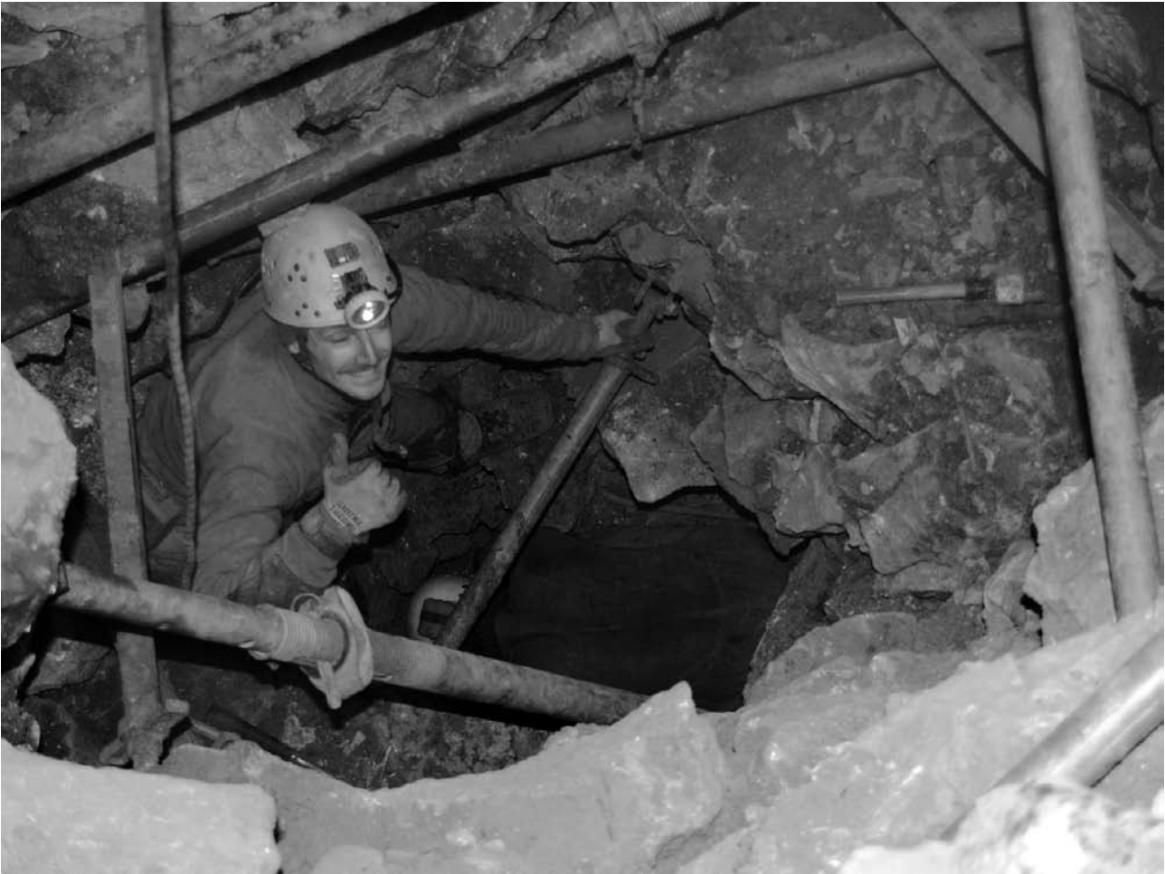
Abb. 4: Die am zweiten Grabungstag noch vorherrschende, leicht riskante „Walisische Vortriebs- und Verbautechnik“; Foto: Thilo Müller
